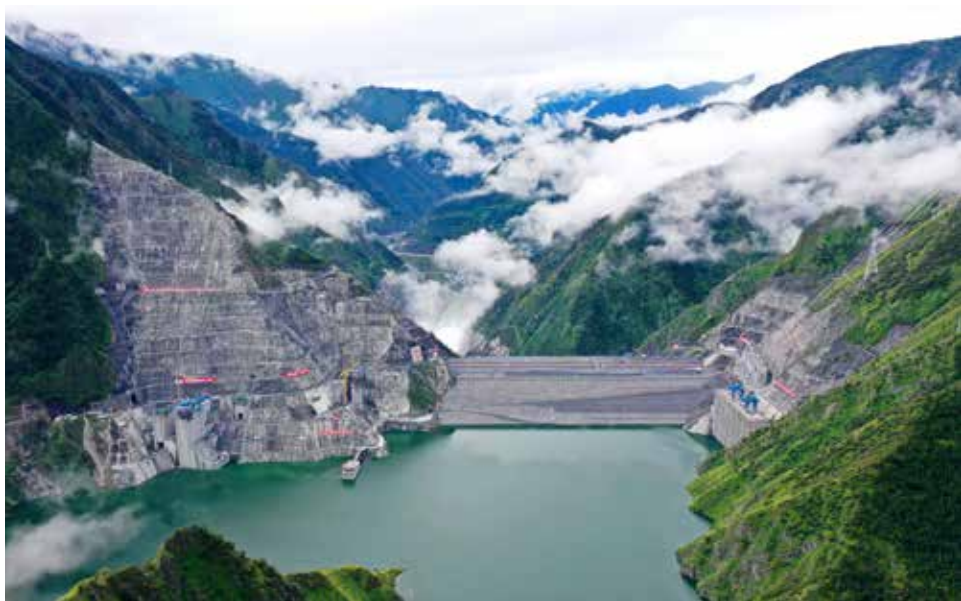
雅砻江两河口水电站
